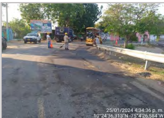
Fotografía 12. Trabajos de parcheo. Tramo Santa Lucía Villa Rosa UF0.
