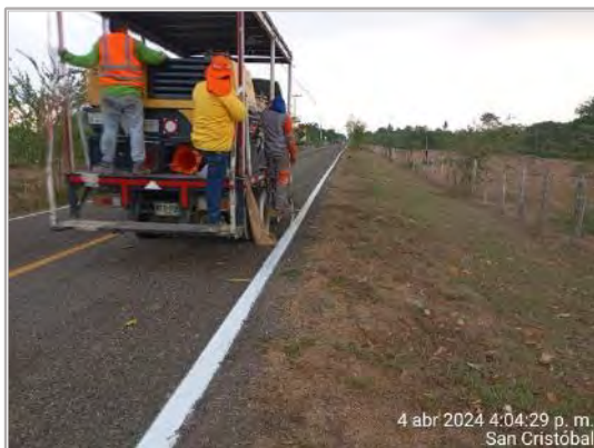
Fotografía 14. Demarcación señalización horizontal. Tramo Calamar - Santa Lucía UF0.
