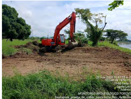
Fotografía 42. Monitoreo forense DES_001_SANTA_LUCÍA. Excavación de Descapote
