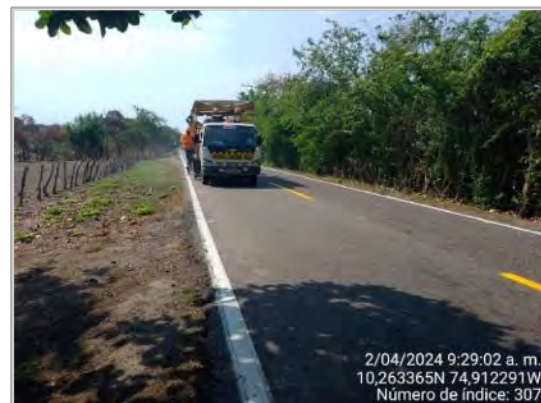
Fotografía 15. Demarcación señalización horizontal. Tramo Santa Lucía – Villa Rosa UF0
