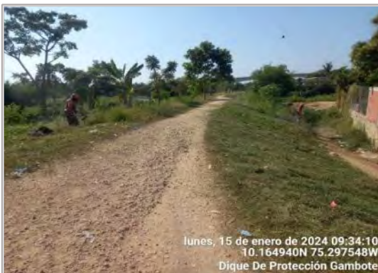
Fotografía 8. Limpieza Dique de protección Santa Lucía UF0.
