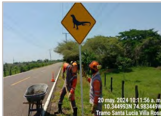
Fotografía 18. Instalación de señales verticales. Tramo Santa Lucía- Villa Rosa UF0.
