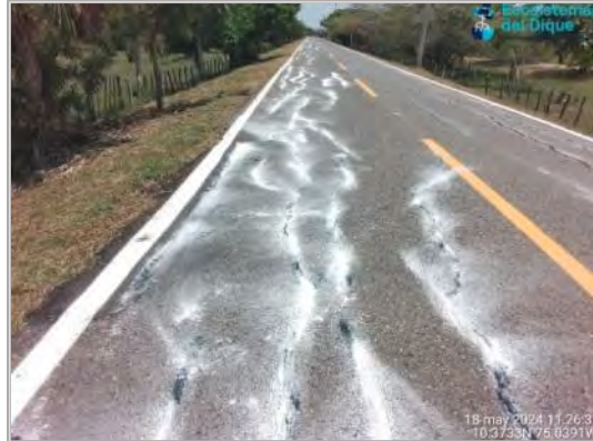
Trabajos de Sellado de fisuras. Tramo Santa– Villa Rosa UF0.
