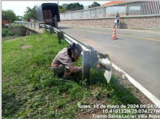
Fotografía 19. Trabajos de soldadura para reforzar defensas metálicas. Tramo Santa Lucía – Villa Rosa UF0.
