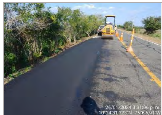
Fotografía 13. Trabajos de parcheo. Tramo Santa Lucía Villa Rosa UF0.
