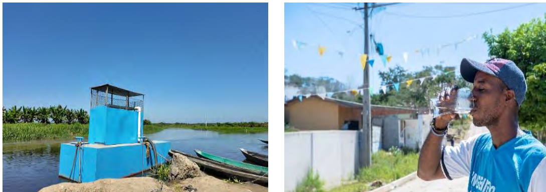
Fotografía 32. Repotenciación de la planta de tratamiento de agua potable.
