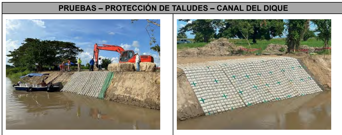
Fotografía 1. Prueba protección taludes - FLEXAMAT.
