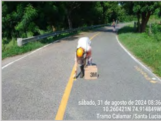
Fotografía 16. Instalación de tachas reflectivas. Tramo Santa Lucía – Villa Rosa UF0.
