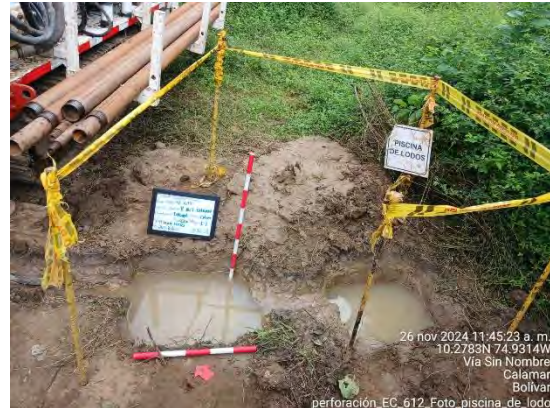
Fotografía 41. Monitoreo forense P_007_CALAMAR. Piscina de lodo y perforación
